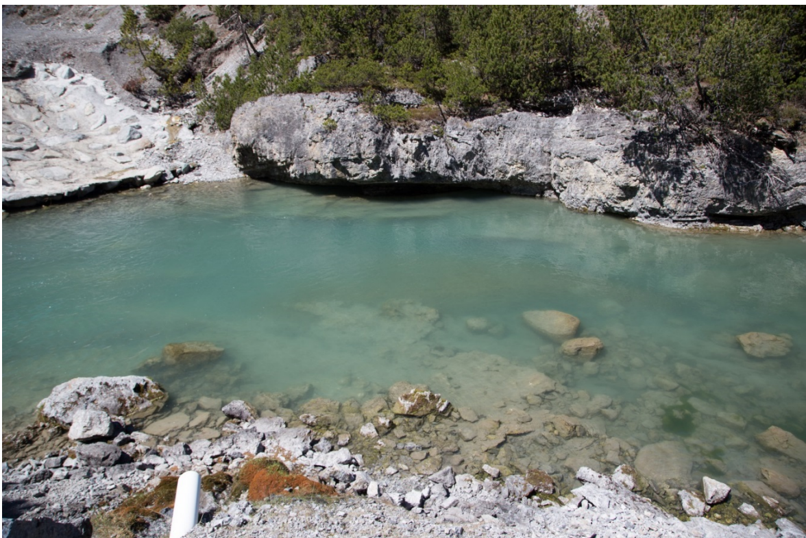
Zu reinigendes Tosbecken unterhalb der Staumauer Punt dal Gall
