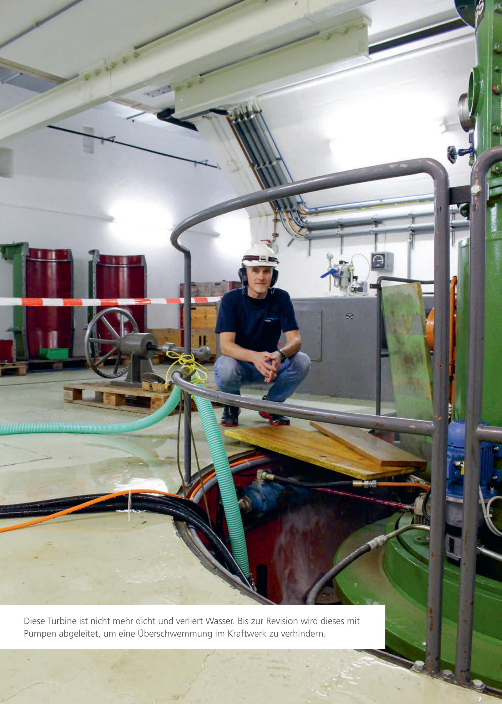
Diese Turbine ist nicht mehr dicht und verliert Wasser. Bis zur Revision wird dieses mit Pumpen abgeleitet, um eine Überschwemmung im Kraftwerk zu verhindern.
