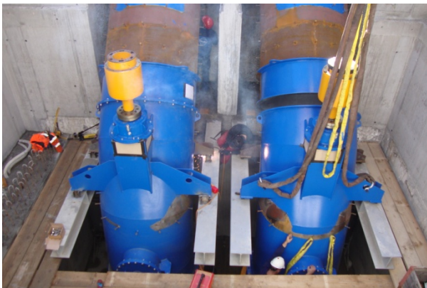
Foto 2: Las duos turbinas identicas dal tip "caplan" illa centrala da l'implant
